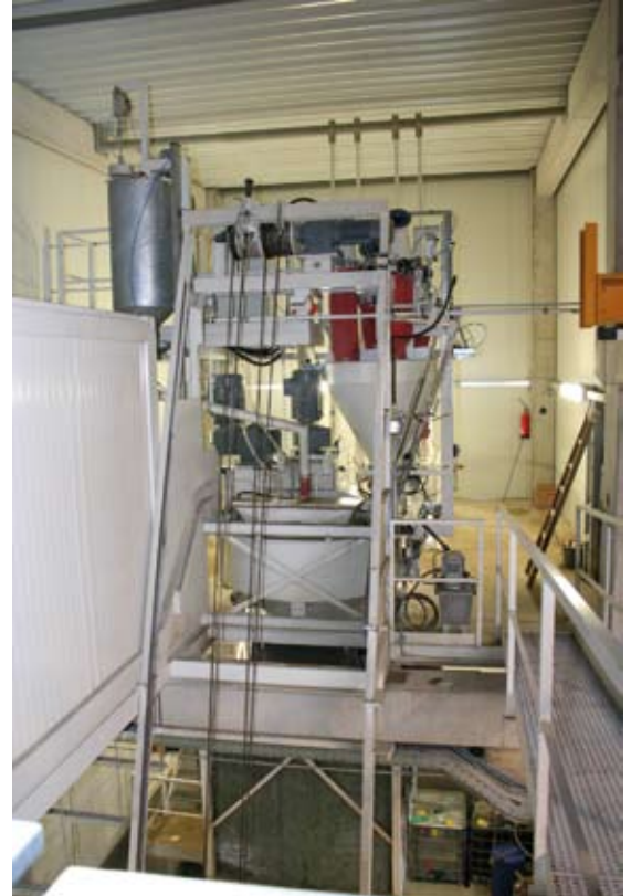
Abb. 9 Der Mischer wird über den Kippkübelaufzug mit Absturzsicherung mit den Ausgangsmaterialien gespeist.
