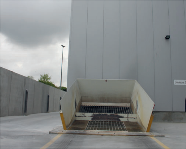
Les silos à granulats sont d'abord alimentés depuis l'extérieur par une trémie de chargement pour camions
