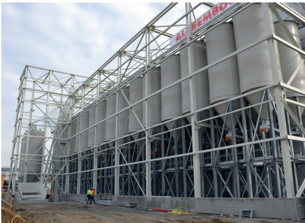
Chacun des silos en plastique de 40 m 3 contient notamment différents sables et gravillons dans une grande variété de couleurs
